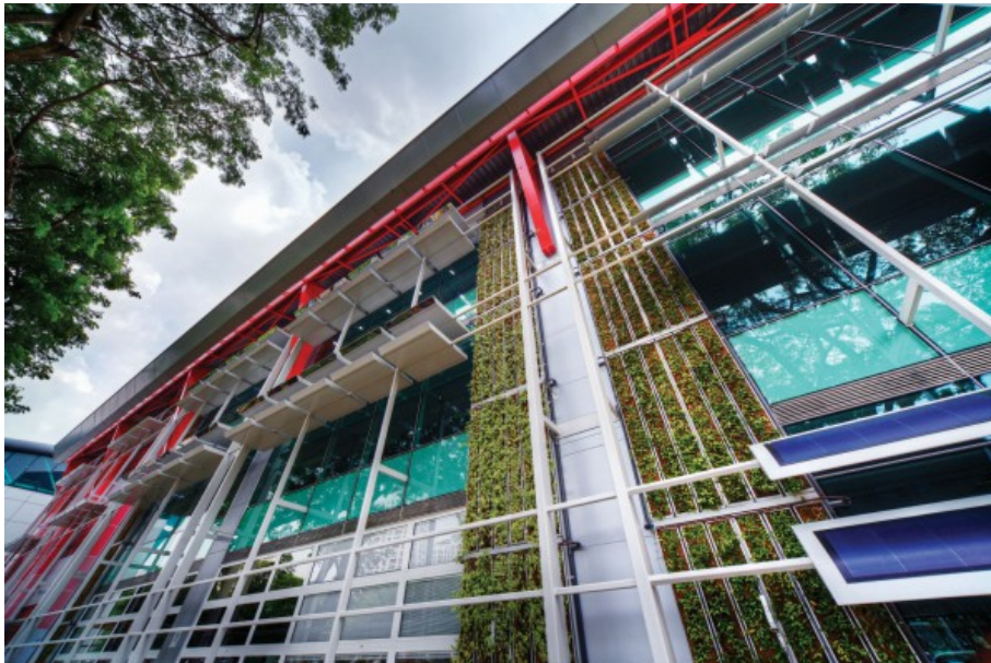
ภาพที่ 1: Zero Energy Building (ZEB) ในประเทศสิงคโปร์ ออกแบบให้กรอบอาคารสามารถป้องกันความร้อนจากภายนอก และสร้างระบบการใช้พลังงานทดแทนภายในอาคารด้วยตัวเอง
